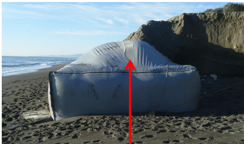
変形に伴う張力増加によって考えられる縫製部の損傷例
