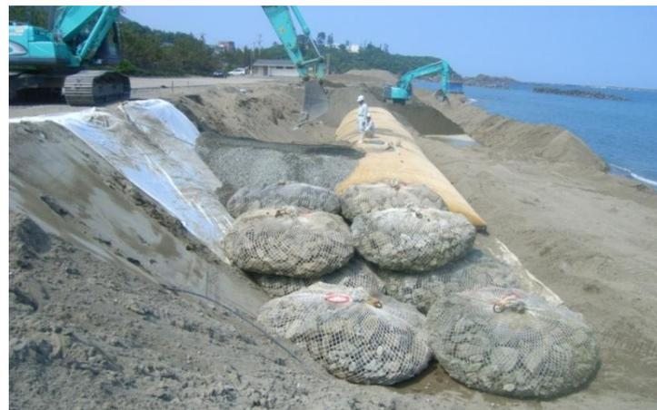
フィルター材による端部処理例
