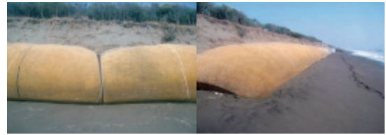
完成状況 (覆砂前)
