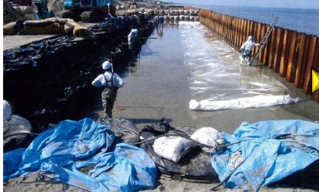
①洗掘防止シート敷設
